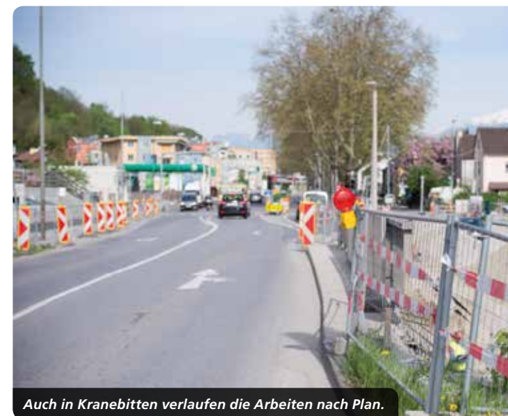
Die neue Landesstraße entsteht neben der alten Kranebitter Allee.
