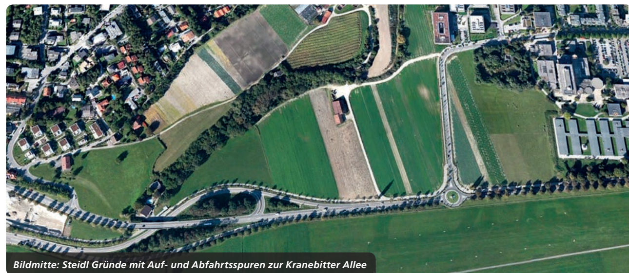
ÖBB Verknüpfungspunkt am ÖBB Bahnhof in Völs.
