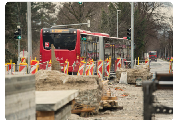
Die Arbeiten in der Kranebitter Allee stören den Verkehr nicht.
