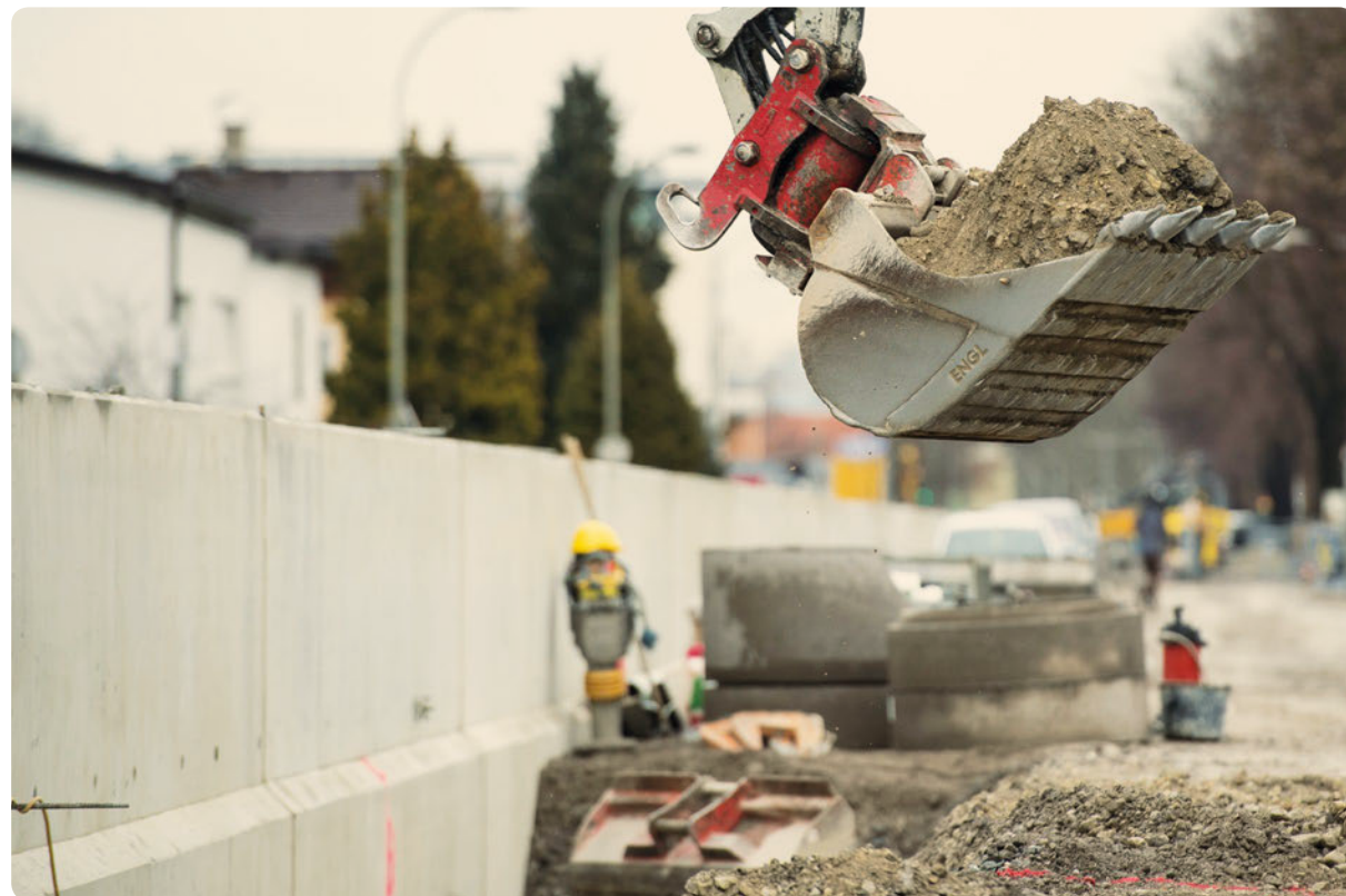
In der Kranebitter Allee geht es nach der Errichtung der neuen Landesstraße nun mit der eigenen Trasse für die Tram weiter.
