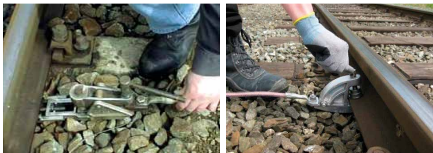
Abbildungen 14a und 14b: Befestigen der Schienenfußerdungsklemme
