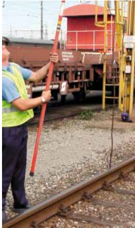
Abbildung 14c: Aufrichten der Erdungsstange
