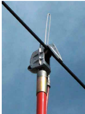
Abbildung 14f: Einhängen der Fahrdrahterdungsklemme
